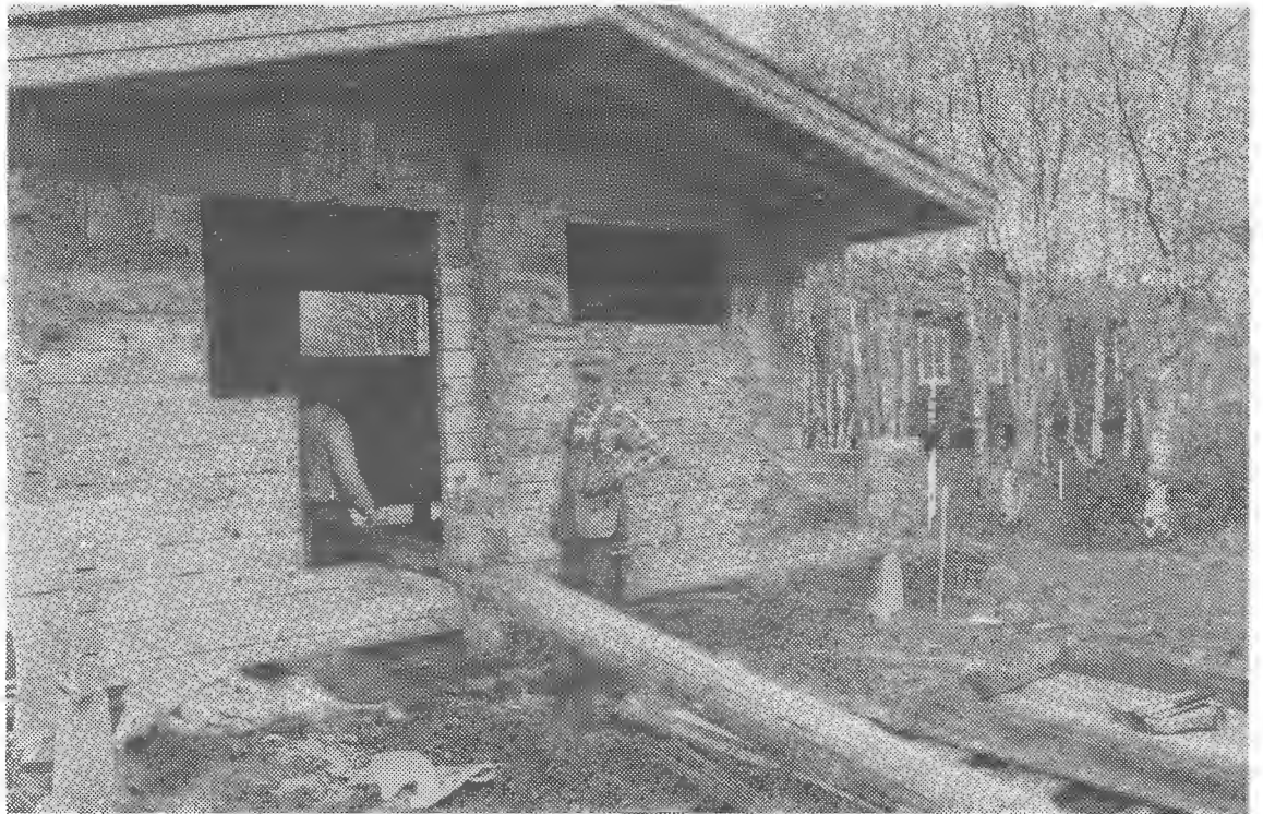
Kirvesmies Eino Koivikko (kuvassa) oli ahkerimpia talkoolaisia, kun veneilykeskukseen rakennettiin uutta saunaa. Kuva otettu kesäkuun alkupäivinä, sauna valmistui käyttökuntoon heinäkuussa -81.
